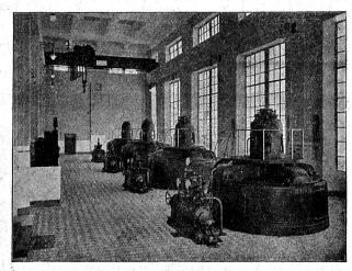
Usine de la Jogne. (Entreprises Electr. Fribourgeoises) 4 turbines de 7800 ch. chacune. Chute: 105-120 m. Vitessel: 500 t/min
