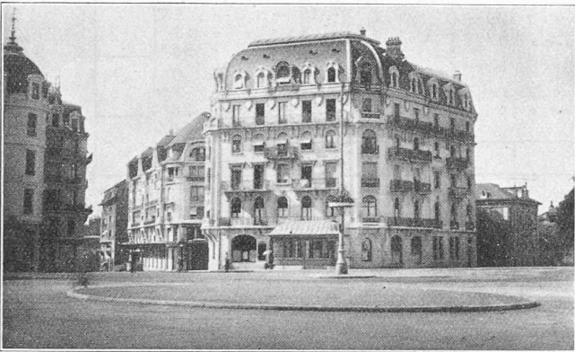
Vue prise du point A.
