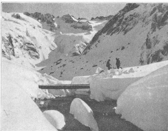
Fig. 10. — Emissaire du lac de Gelmer. Profil de jaugeage. A droite, en arrière de la passerelle, toit du limnigraphe.
