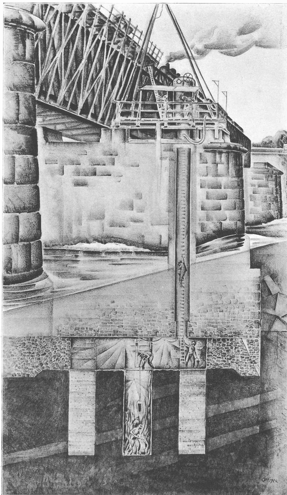
Fig. 4. — Reprise en sous-œuvre de la fondation, durant l'excavation du pilier 3.
