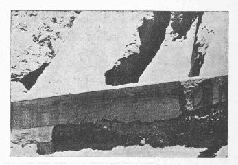
Fig. 13. — Fissure horizontale au pied des voûtes du secteur de droite.
