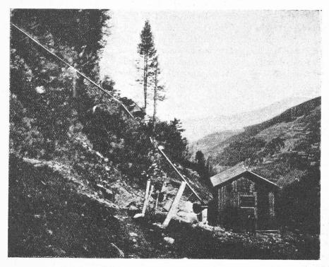
Fig. 1. — Conduite forcée en tubes de fer électrolytique Bévé. Hauteur: 100 m. — Diamètre: 20 cm. — Epaisseur: 2 mm.
