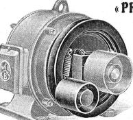
avec tendeur de courroie breveté fixé directement sur le moteur, n'exige pas de montage spécial.
