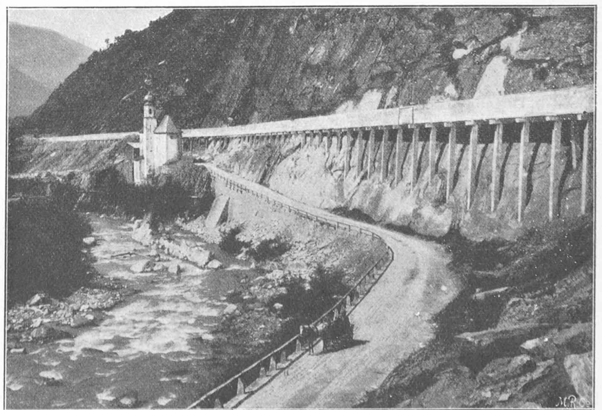
Fig. 2. — Aqueduc de Mœrel à Brigue.
