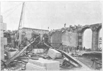
Fig. 4. — Chute d'un bloc de pierre au rez-de-chaussée de l'Hôtel des Postes, en construction, à Lausanne.
