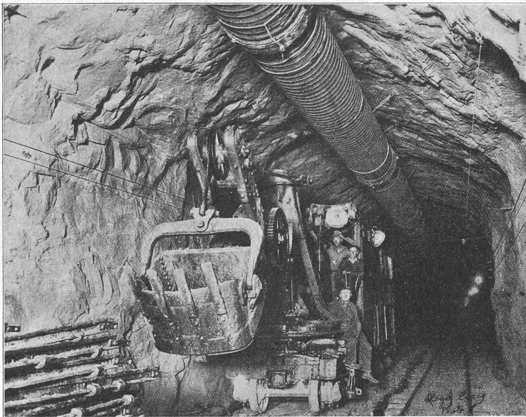
Fig. 3. — Pelle mécanique dans la galerie du lac de Florence.
