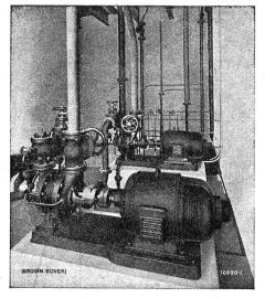
Deux moteurs à démarreur centrifuge entraînant des pompes aux abattoirs de Bâle.
