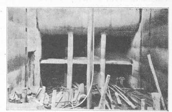
Fig. 7. - Entrée d'une chambre spirale.
