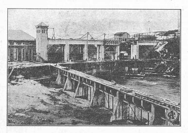
Fig. 3. — Bâtiment des turbines et barrage. Vue prise en amont, de la rive gauche.
