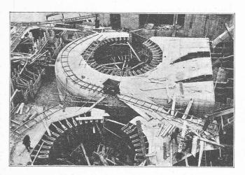
Fig. 8. — Coffrage des chambres spirales.
