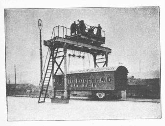
Fig. 1. — Ancienne installation, commandée à bras, de la gare de Zurich.
