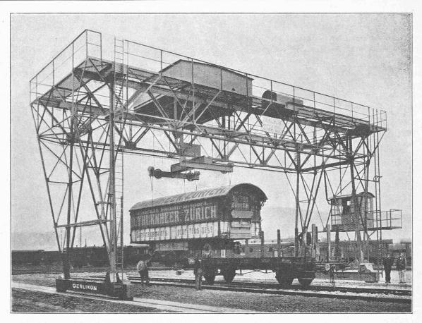
Fig. 3. — Portique roulant de 25 tonnes, à la gare de Zurich.
