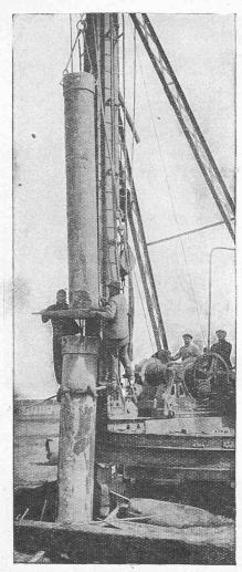
Fig. 3. — Mise en place du deuxième tube dans le premier.
