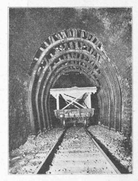
Fig. 5. — Reconstruction de la voûte d'un anneau du tunnel I, en 1918, au km. 3.964 côté nord.
