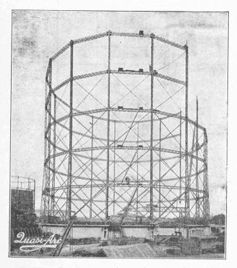
Fig. 12. — Gazogène construit sans rivetage par le procédé « Quasi-Arc ».
