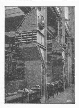
Fig. 15. — Réchauffeur d'air, construction Sulzer, utilisant des éléments Sendric, dans l'atelier de bobinage ci-dessus. Les ventillateurs sont mus par des moteurs électriques.
