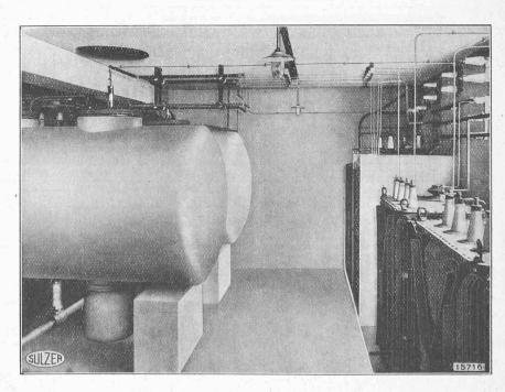
Fig. 18. — Vue des accumulateurs de chaleur de l'installation ci-dessus. Introduction du courant par le bas; à droite les transformateurs.
