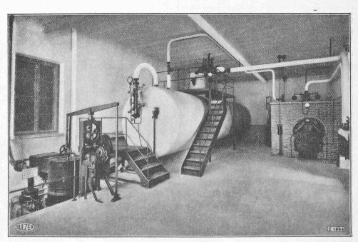
Fig. 16. — Installation de la maison Sulzer Frères, à Winterthur. Accumulateur de vapeur et chaudière électrique dans le bâtiment de la filature de coton et tissage de Wettingen près de Baden
