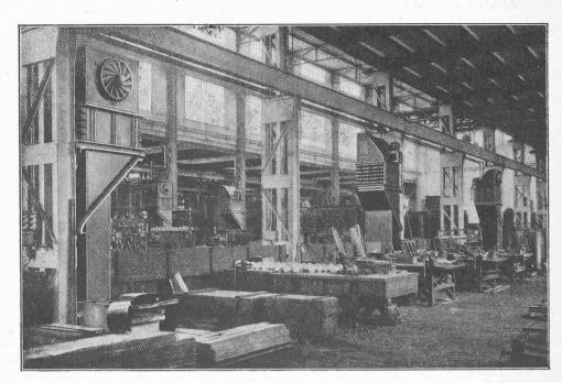
Fig. 14. — Partie du nouvel atelier de bobinage de MM. Brown Boveri et C<sup>1e</sup>, à Baden, avec réchauffeurs d'air, construction Sulzer.
