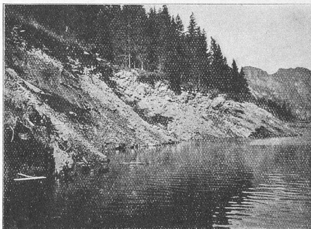
Fig. 51. — Vue partielle de la berge écoulée prise après que le niveau du lac eut remonté d'une quinzaine de mètres.
