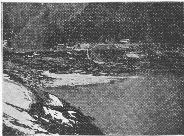
Fig. 53. — Affaissement de berge et effets d'érosion à l'extrémité sud du lac.
