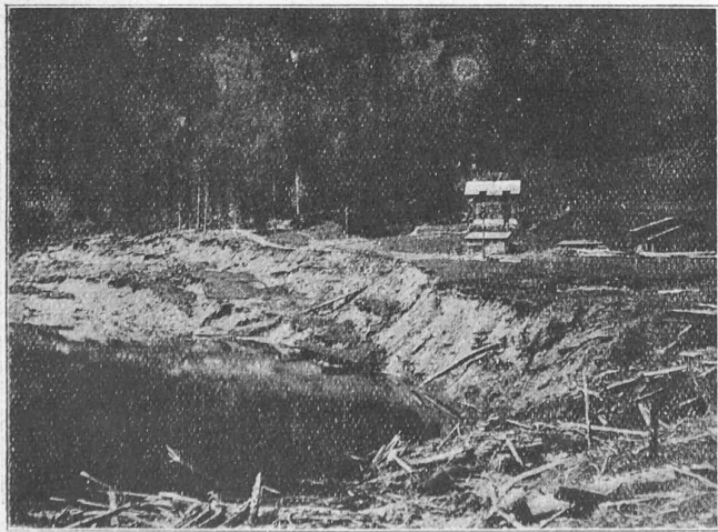
Fig. 50. — Affaissement de berge.
