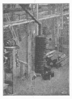
Fig. 2. — Poêle en fonte, dit «poêle Hohenzollern».
