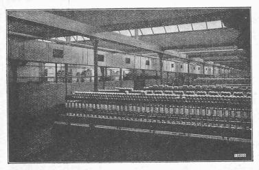
Fig. 9. - Chauffage par l'air chaud avec distribution centrale dans une salle de machines à filer. Contruction de Sulzer Frères, à Winterthur.
