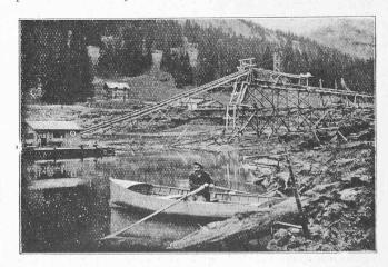
Fig. 40. — L'installation de pompage et l'estacade devant l'émissaire naturel du lac, le 20 novembre 1920, la première tranche d'eau de 9 m. 60 de profondeur étant évacuée.
