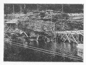
Fig. 41. — Conduite de 40 cm. de diamètre évacuant l'eau élevée par les pompes dans le Puits  $D_3$ .
