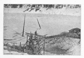
Fig. 47. — L'installation de pompage épuisant la 3º tranche du lac, et déversant son eau dans la conduite se dirigeant vers g<sub>1</sub>.
