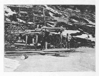
Fig. 48. — Le tuyau de prise au lac et sa crépine. Par pompage, le lac a été abaissé de près de 3 mètres au-dessous du niveau d'écoulement naturel dans le tunnel.
