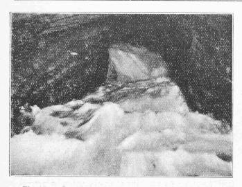
Fig. 45. — La galerie transversale sous le lac reçoit de d $_3$  700 litres par seconde provenant des pompes et d'un syphon de 25 cm. de diamètre.
