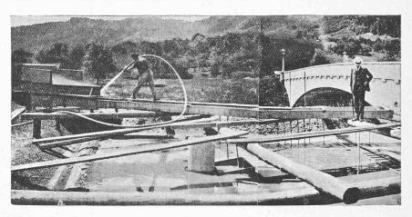
Fig. 1. - Introduction de la terre glaise dans un bassin ouvert, au moyen d'eau.
