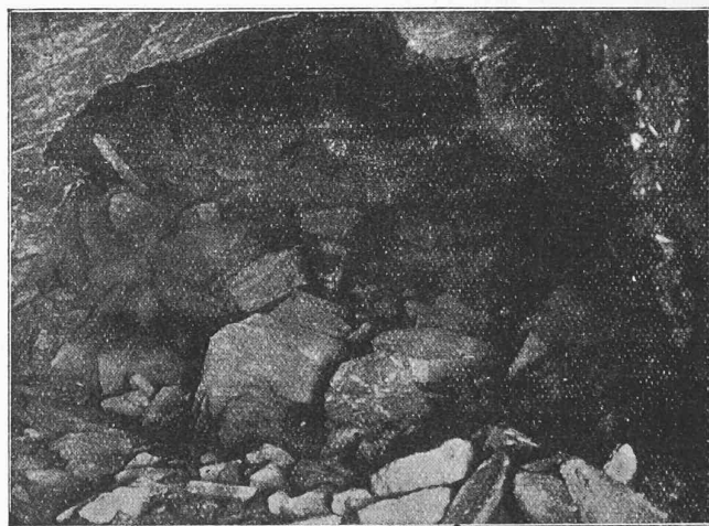
Fig. 34. — Pierraille charriée par l'eau dans la galerie d_1 .
