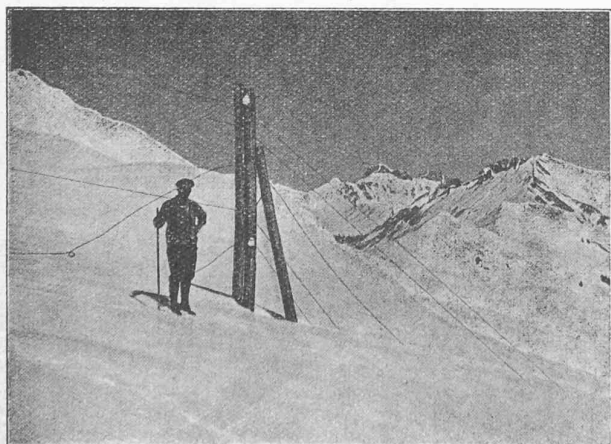
Fig. 26. — Poteau de 12 mètres et les lignes électrique et téléphonique rompues au Col des Andérets. Vue prise le 6 mai 1919.
