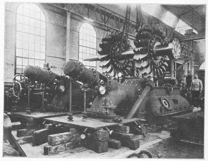
Fig. 4. — Turbine de 14300 chevaux de l'usine d'Amsteg.
