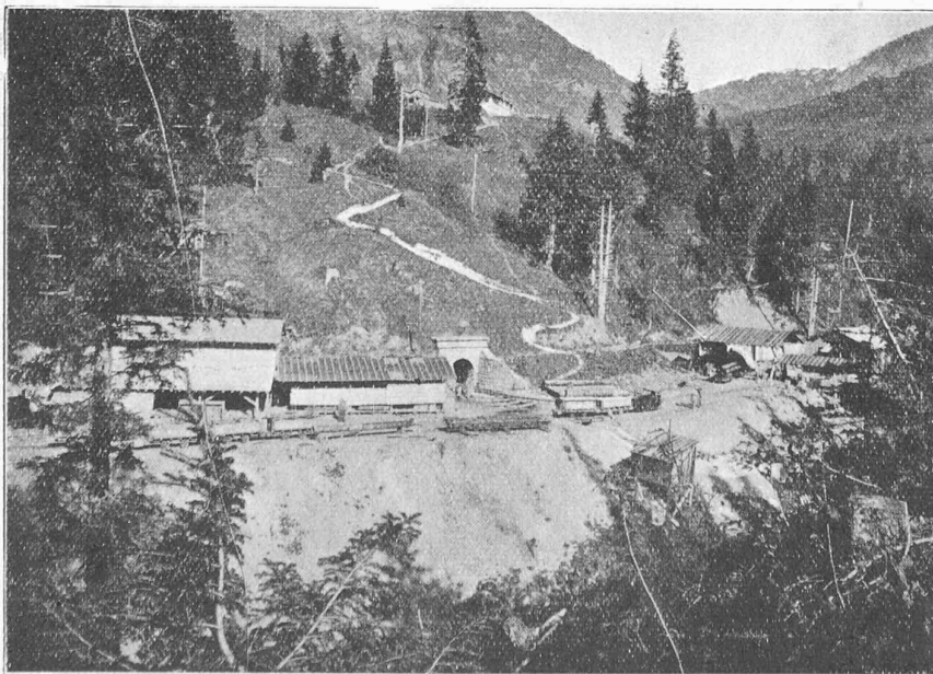
Fig. 22. — Une partie du chantier d'Ayerne avec le portail aval du grand tunnel.
