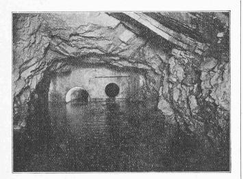
Fig. 20. — Face amont du « bouchon » fermant le grand tunnel près de son extrémité inférieure.
