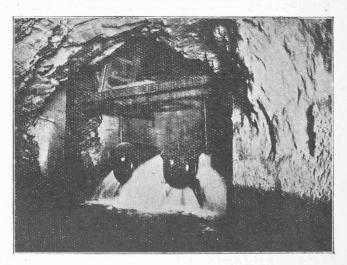
Fig. 16. — Les vannes nº 3, à la base du Puits II, débitant 200 litres par seconde.
