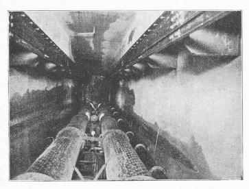
Fig. 12. — Vue de haut en bas dans le Puits I. On voit, au fond, l'eau venant du lac presque vide et s'écoulant dans le grand tunnel.
