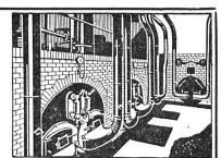
installation de soufflerie sous grille « Fæhn » pour combustibles pauvre
