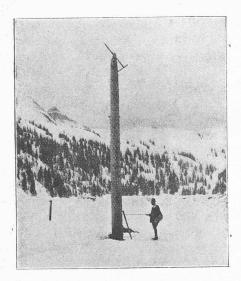
Fig. 6. Le «sapin limnimètre», à lac abaissé de 8 m., Le liteau horizontal fixé à son faîte indique le niveau normal du lac.
