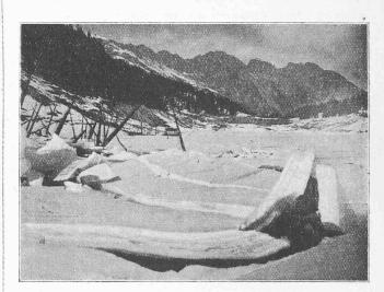
Fig. 5. — Fûts de sapins dans le lac d'Arnon gelé abaissé de 25 m. Dislocation de la glace provoquée par l'abaissement du lac.
