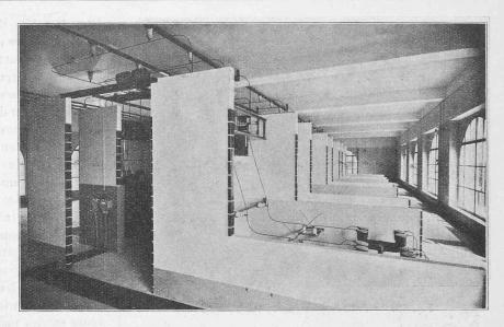
Fig. 40. — Appareils de protection des départs à 6000 v.
