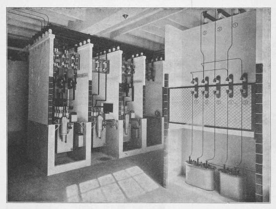
Fig. 38. — Appareillage du régulateur d'induction.
