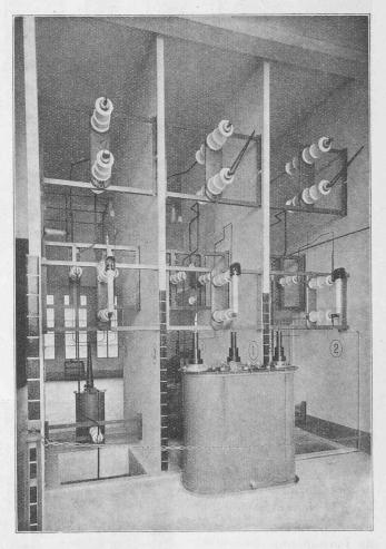
Fig. 37. — Transformateurs pour les appareils de mesure.
