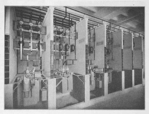
Fig. 39. — Interrupteurs des transformateurs de 800 kVA.
