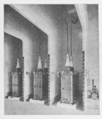
Fig. 36. — Interrupteurs à 50 000 V.
