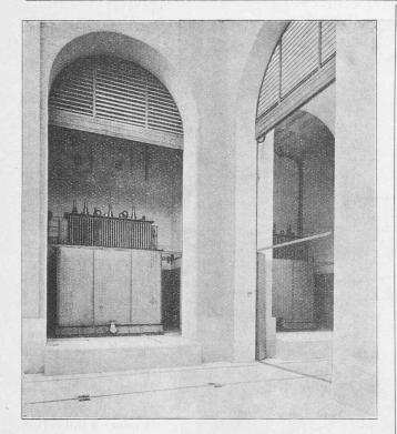
Fig. 35. — Transformateurs de 5000 kVA.
