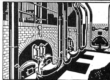
Installation de soufflerie sous grille « Fahn » pour combustibles pauvres
