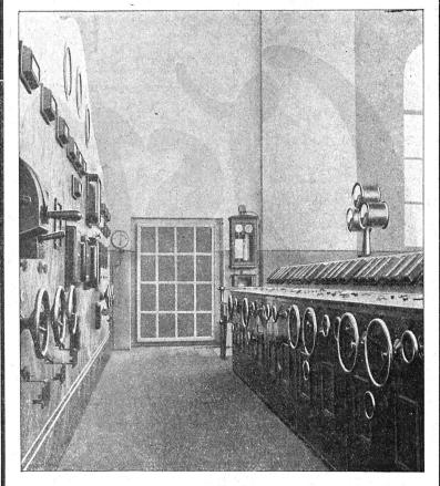
TABLEAU DE DISTRIBUTION ET PUPITRE (Station centrale électrique de Massaboden pour les CFF. à Brigue)
