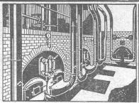
installation de soufflerie sous grille « Fæhn » neur combustibles nauve
