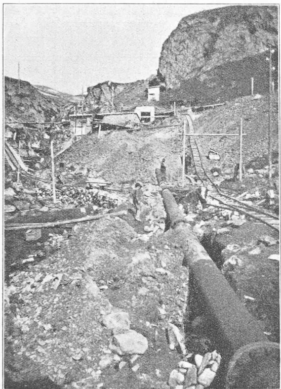
Fig. 25. — Montage et remblayage de la conduite sous pression.
