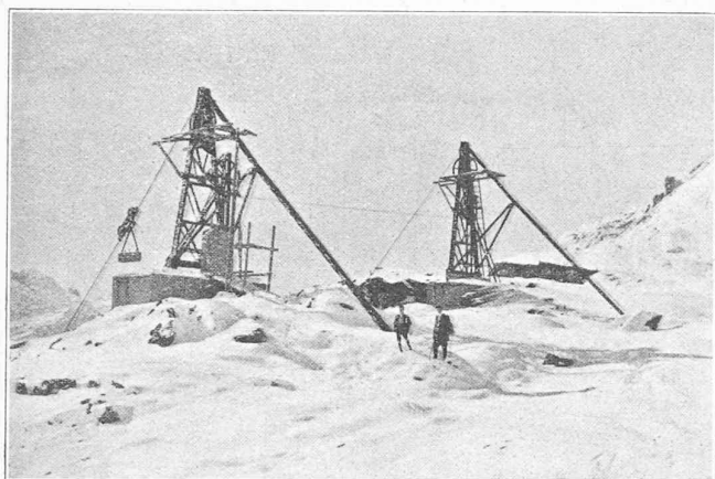
Fig. 30. — Câble aérien. Station supérieure.
