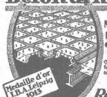
SYSTÈME KEPPLER BREVETE Nouveau système de plafonds translucides en béton armé et dalles de verre
