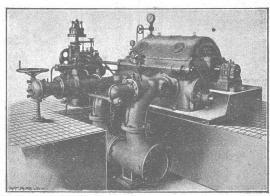
Usine électrique de CARTAGO (Costa Rica). Turbine Pelton de 485 HP. sous 107 m. de chute.
