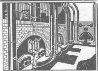
installation de soufflerie sous grille «Fæhn» pour combustibles pauv
