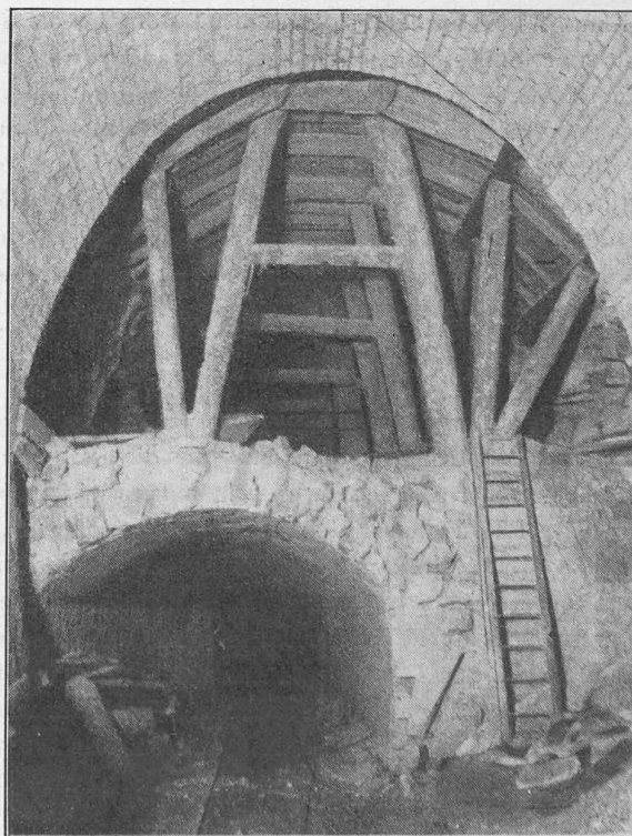
Fig. 2. — Excavation suivant la méthode belge dans la roche sous pression.
