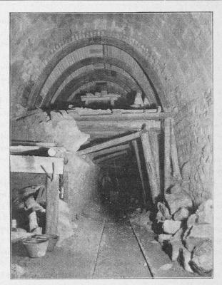
Fig. 4. Revêtement du tunnel dans la roche décomposée.
