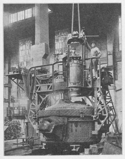
Fig. 2. Démontage d'un économiseur *Fiat* sur un four électrique en fonctionnement.
