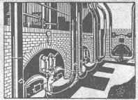
installation de soufflerie sous grille «Fæhn» pour combustibles pauvr
