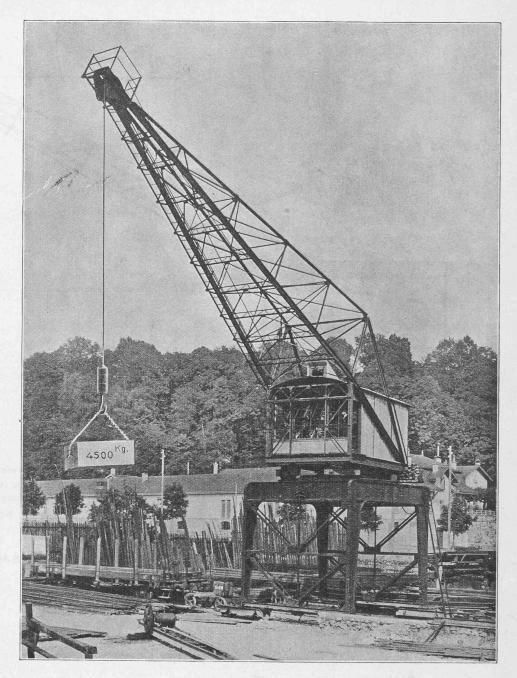
Fig. 1. — Grue roulante et pivotante, sur portique.
