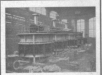
Turbines hydrauliques | Système Francis et Roues tangentielles Régulateurs universels
