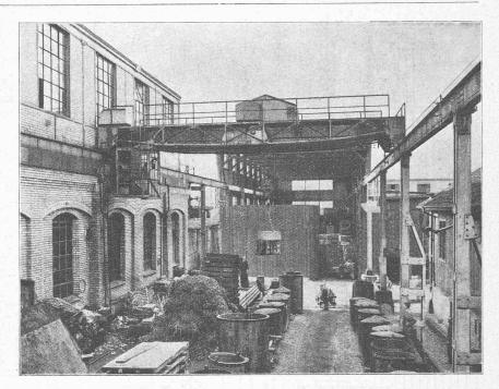
Fig. 2. — Pont-roulant avec électro-aimant de levage.
