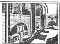
installation de soufflerie sous grille « Fæhn » pour combustibles pauvr
