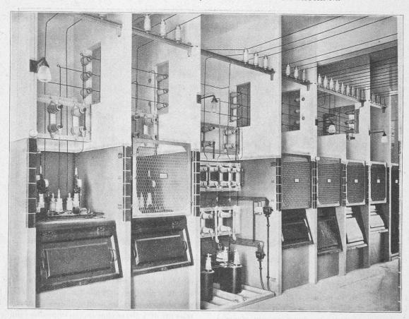
Fig. 21. — Appareillage des départs à 6000 volts.
