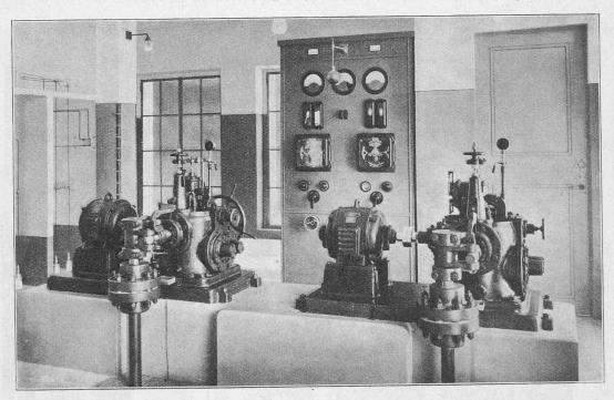
Fig. 20. — Servo-moteurs des régulateurs d'induction.
