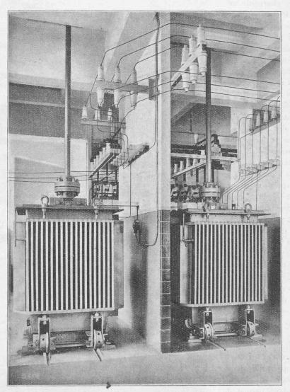
Fig. 19. — Régulateurs d'intensité.
