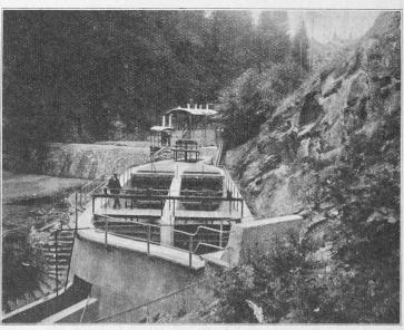
Fig. 31. — Dessableur du Pont-du-Pas, vue de l'aval vers l'amont.
