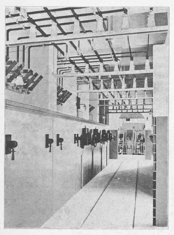
Fig. 13. - Barres collectrices à 6500 volts.
