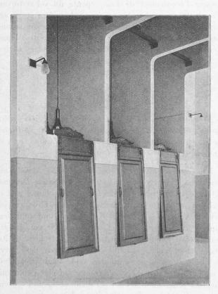
Fig. 15. — Interrupteurs unipolaires à 50 000 volts.
