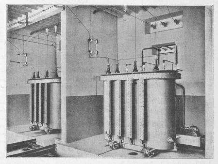
Fig. 14. — Transformateurs de 7500 kVA.
