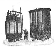
TRANSFORMATEUR MONOPHASÉ 5000 kVA 60 000/15 000 v. 16  $^2l_3$  pér. Fourni aux CFF pour la sous-station de Giubiasco.
