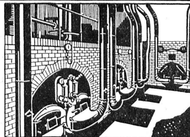
Installation de soufflerie sous grille « Fohn » pour combustibles pauvres
