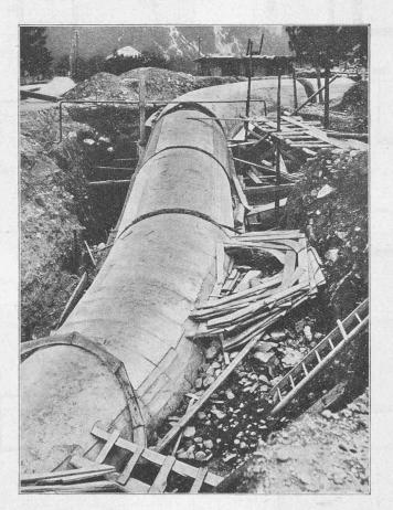
Fig. 7. — La conduite avant le rejointoyage des tronçons.
