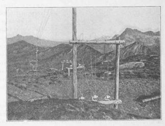
Fig. 11. — Tête amont de la ligne de secours.
