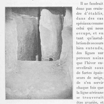
Fig. 9. — Intérieur de la tranchée creusée au col des Andérets pour soustraire les poteaux à l'action de la poussée de la neige. On dis-tingue la tête d'un homme qui est debout à côté des poteaux; à ses pieds il y a encore 1,20 m. de neige.
