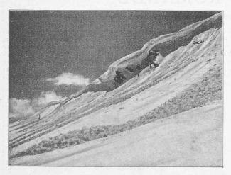
Fig. 3. — Le versant est du col des Andérets. On distingue un poteau contrefiché de la ligne aérienne qui résiste encore aux assauts des débris provenant de la rupture de la corniche.
