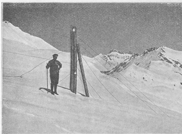
Fig. 2. — Le col des Andérets. Poteau de 12 m. Les 3 fils haute tension sont rompus, ainsi que les 2 fils téléphoniques. Le trait de lumière, à droite, en bas, marque le bord supérieur de la corniche.
