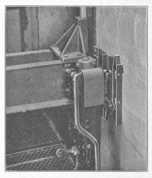
Fig. 9. — Commutateur « micro » sur la cabine.
